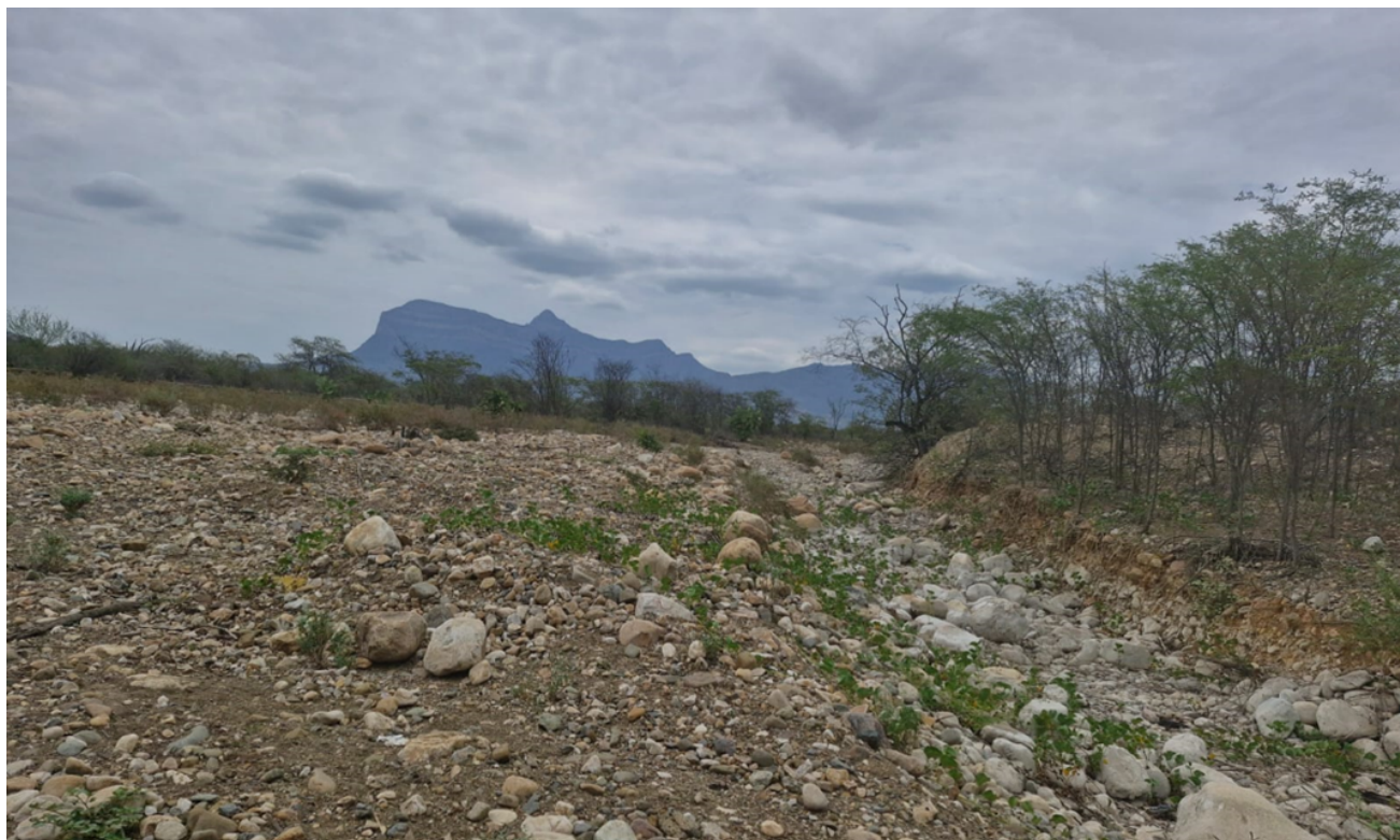
ZONA COLMADA DEL SECTOR MIRADOR DONDE SE PUEDE APRECIAR LA FALTA DE DESCOLMATACION AL CAUCE LO CUAL GENERAN EROSIONES LA CUAL SIGUE AVAZANDO
